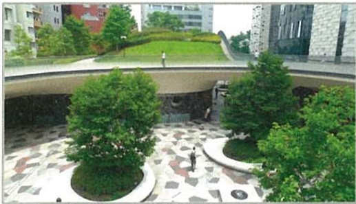
にぎわい施設のある広場や、みどり豊かなデッキ上の動線など重層的なネットワーク
