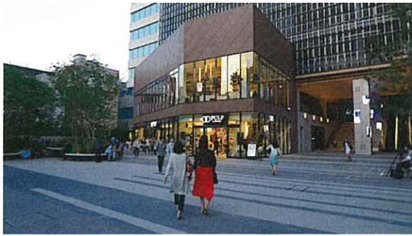
避難者等をスムーズに受け入れる 歩道と一体となった間口の広いオープンスペース
