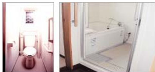
主要な場所への手すりの設置
