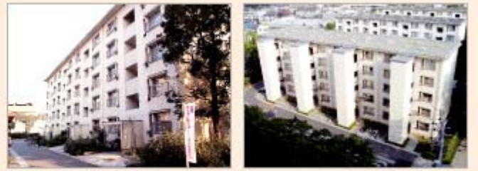
エレベーターの取り付け (福生団地)
