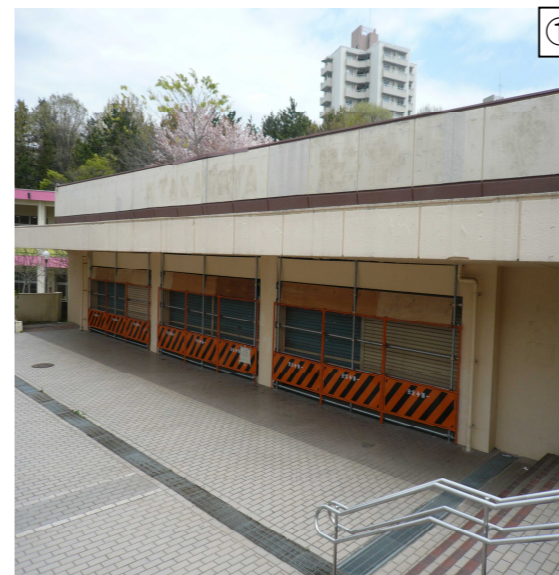
諏訪センターの空き店。舗食料品、最寄り販売店の撤退が目立つ
