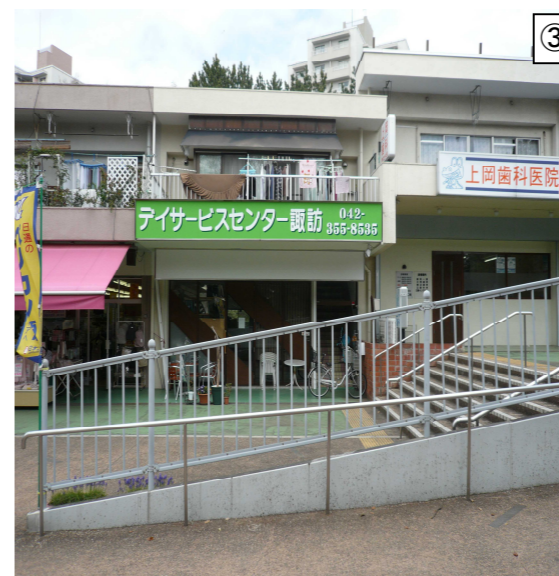
高齢者向け施設が入居した空き店舗
