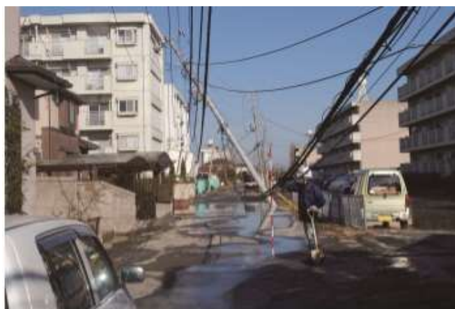
図表 2-37 地震発生時に倒壊した電柱（千葉県香取市）
