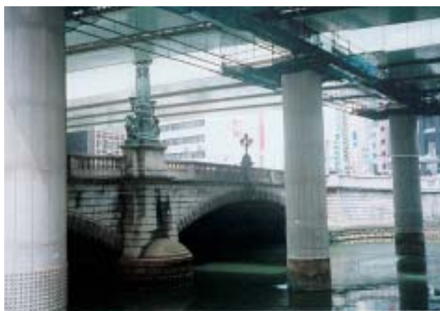
〈日本橋の現況〉
